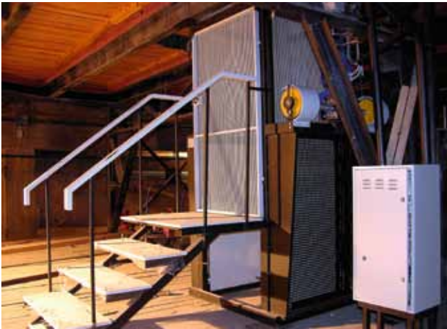
Современный люк провала
